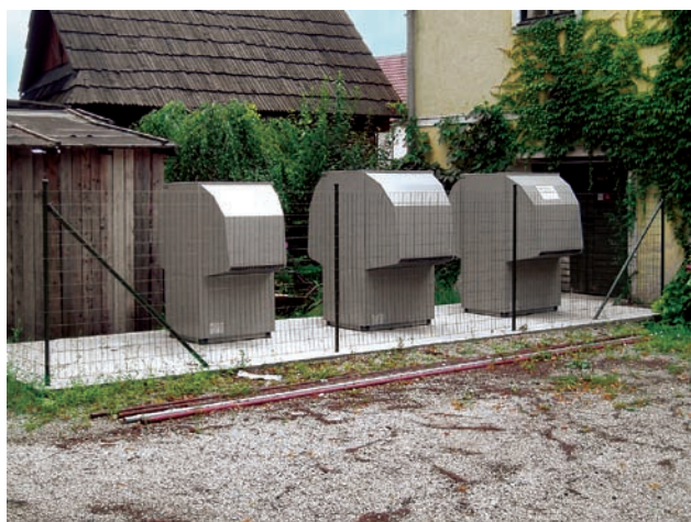
V hotelovém komplexu byla zvolena dvě tepelná čerpadla DIMPLEX LA 28 AS pro vytápění a DIMPLEX LA 11 PS k ohřevu vody
